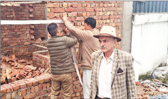
बहादुरगढ़। पटेल नगर में एक निर्माणाधीन भवन को सील करती टीम।
